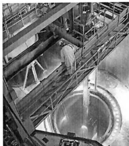
Figura 3.2 - Piscina de Combustíveis Usados e a Máquina de Recarga da usina de Angra II [5]
