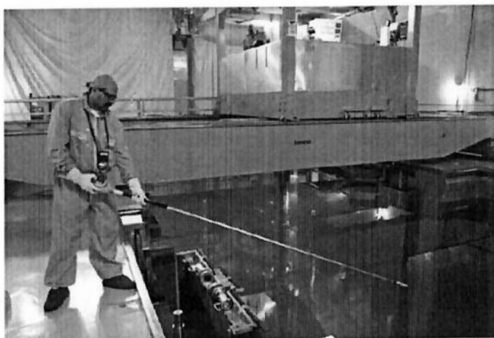
Figura 3.2 - Piscina de Combustíveis Usados e a Máquina de Recarga da usina de Angra II [5]
